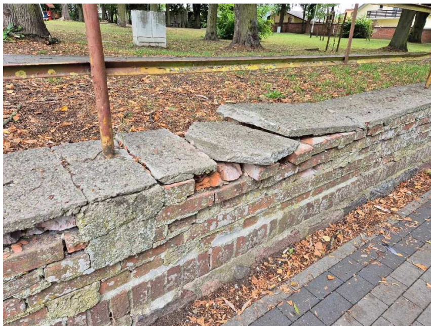
Fot. 1 Zdegradowany murek na odcinku F-G (zniszczona czapka betonowa, znaczące uszkodzenia cegły)
